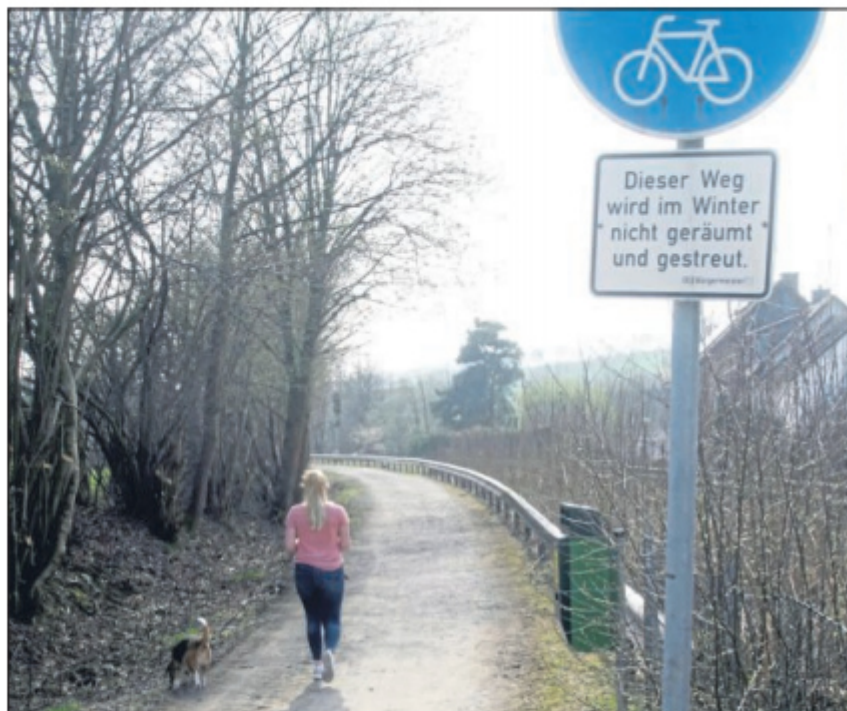
Wird gemacht: Der Fuß- und Radweg auf dem Bahndamm von Allershausen bis Uslar soll saniert werden.
