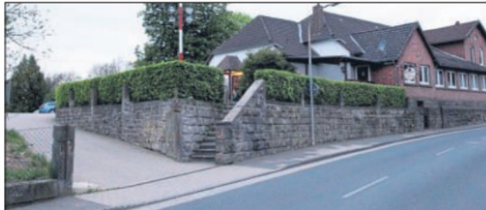
Dorfgemeinschaftshaus Allershausen: Die Ausfahrt wird breiter, um gefahrlos über den Bürgersteig auf die Göttinger Straße einbiegen zu können. Foto: Niesen
