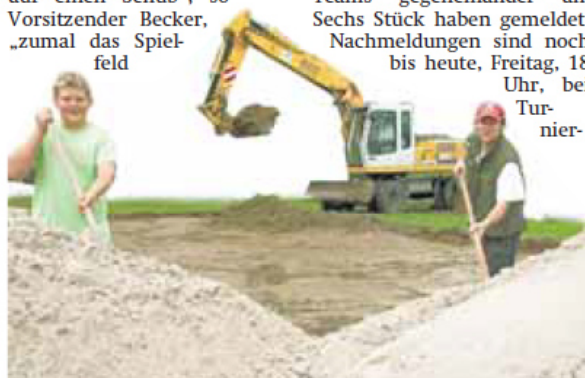
Voller Einsatz für Rot-Weiss: Jan Polnau (links), Thomas Becker und Andreas Carls (auf dem Bagger) bei der Arbeit am neuen Beachvolleyballfeld in Allershausen.
